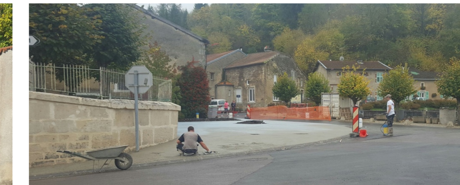
Travaux de terrassements, remplacement de canalisations d'eaux pluviales, pose de bordures et pavés
