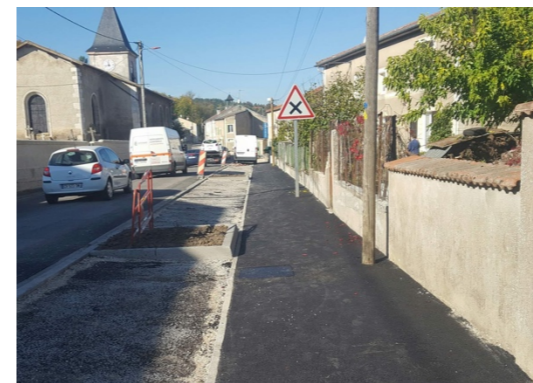
Travaux de terrassements, remplacement de canalisations d'eaux pluviales, pose de bordures et pavés
