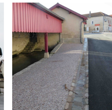
Travaux de revêtement de surface : enrobé, béton désactivé, puis mobilier et plantations
