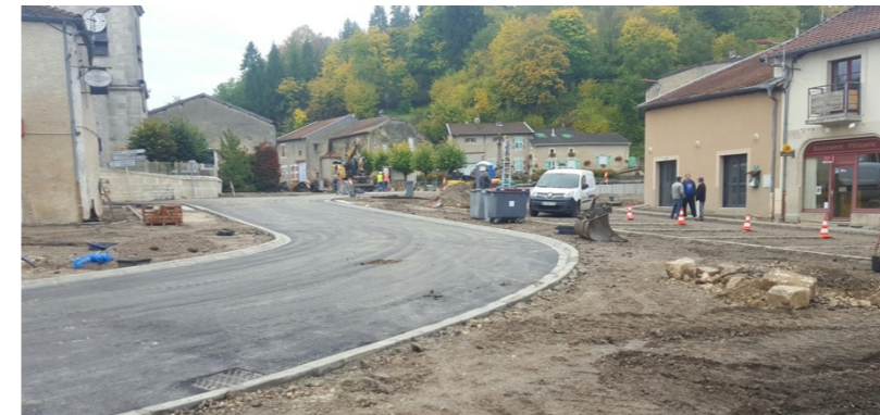
Travaux de terrassements, remplacement de canalisations d'eaux pluviales, pose de bordures et pavés
