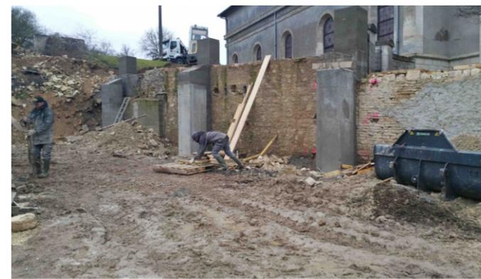
Travaux de préparation et de renforcement des murs de soutènement par des piliers béton
