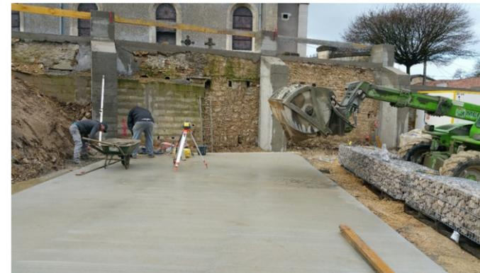
Enduits et couvertine pierre sur murs de soutènement – dalle béton pour zone de jeux
