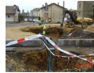
Début de chantier VRD
