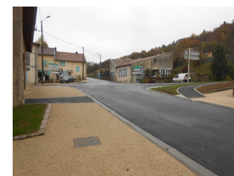
Travaux de revêtements de surface : pavés, concassé, béton et enrobé
