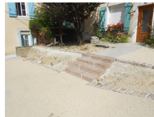
Travaux de terrassements et pose de bordures
