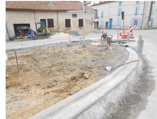
Travaux de terrassements et pose de bordures
