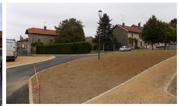
Travaux de revêtements de surface : pavés, béton désactivé, stabilisé et enrobé
