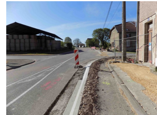
Travaux préparatoires : fin des réseaux secs et terrassements voirie (mars 2017)
