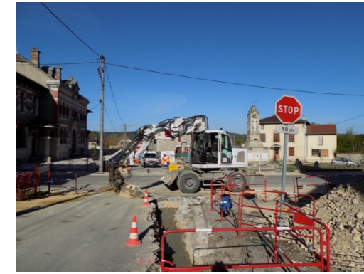
Travaux préparatoires : fin des réseaux secs et terrassements voirie (mars 2017)
