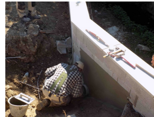
Travaux sur la Place de l'Eglise : mur de soutènement et remblaiement
