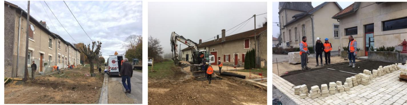
Travaux de terrassements, remplacement de canalisation d'eaux pluviales, pose de bordures et pavés
