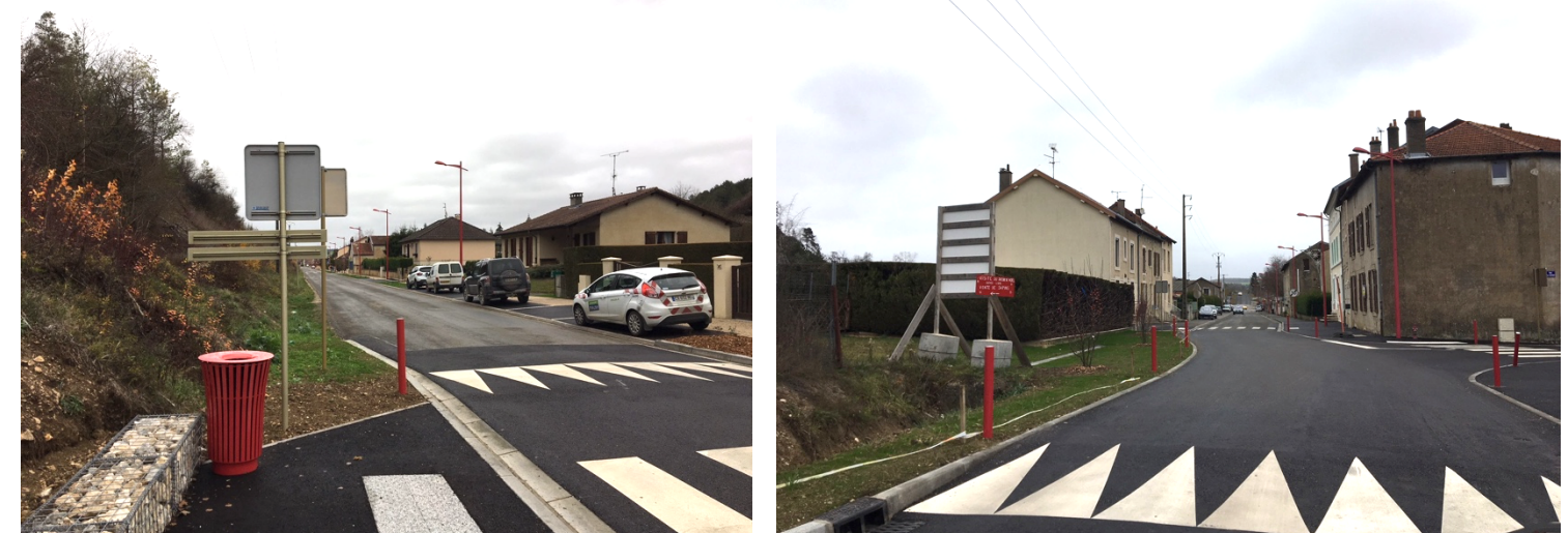
Travaux de terrassements, pose de bordures, béton désactivé, dalles evergreen et enrobé
