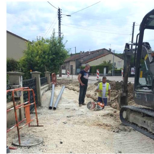
Modification du carrefour RN135/RD120A – Travaux de terrassement et de reprise de réseau d'eaux pluviales
