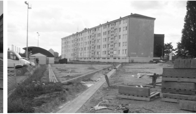
Phase travaux : terrassement et pose des bordures
