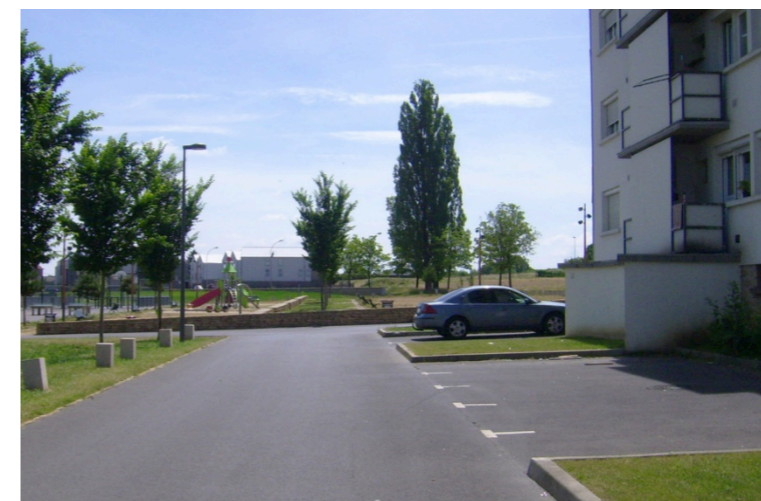
Réalisation : rue et stationnement en enrobé
