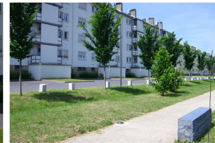
Réalisation : gestion des eaux pluviales par une noue
