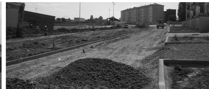
Phase travaux : création de nouvelle rue pour désenclaver l'espace
