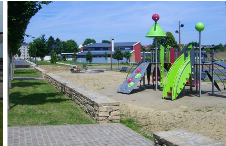
Réalisation : aire de jeux et délimitation de l'espace par des murets en pierres
