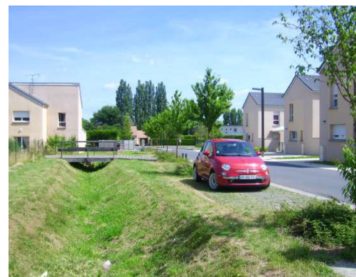
Noue récupérant les eaux pluviales
