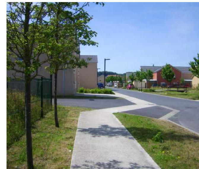
Liaison piétonne en béton balayé
