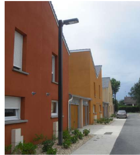
Eclairage de l'espace
