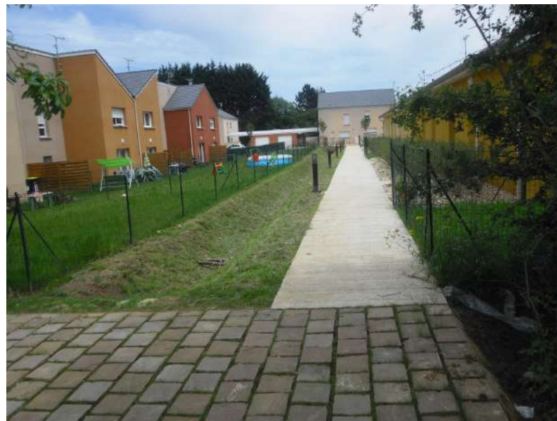
Surface pavée à joints engazonnés
