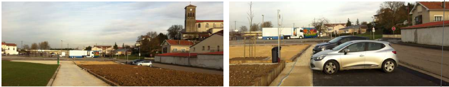
Premiers travaux réalisés par les services techniques de la commune
