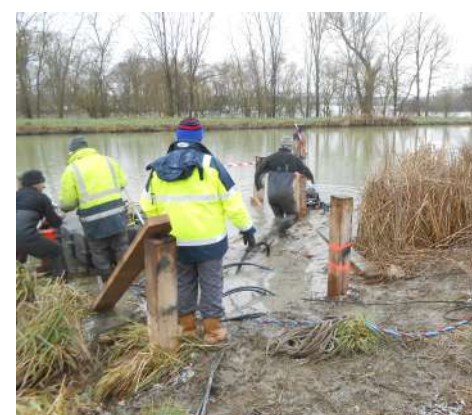
Battage des pieux et contreventements
