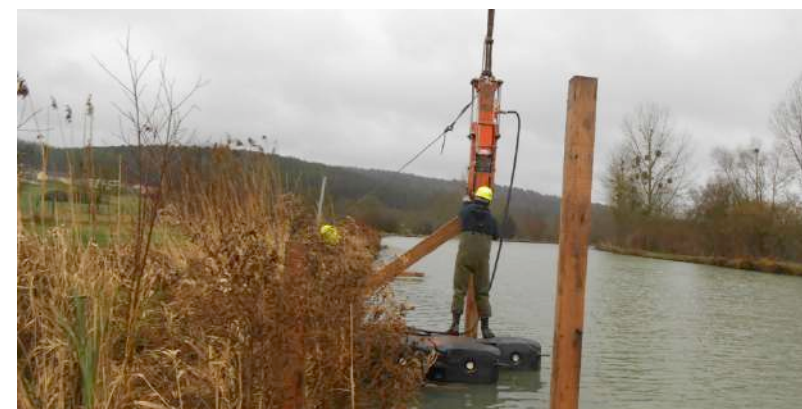
Démarrage des travaux : janvier/ février 2013
