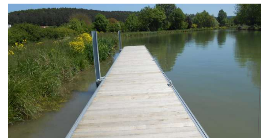
Pont flottant - Halte fluviale
