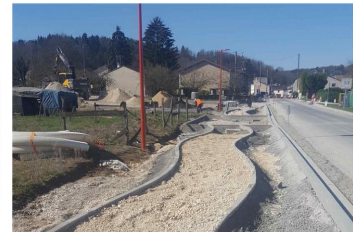
Travaux de revêtement de surface : concassé et enrobé & Travaux de plantations et pose de mobilier
