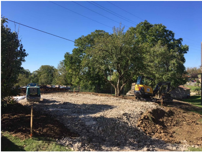
Travaux de terrassement pour création de plateformes tout en conservant les végétaux existants (Fin 2018)
