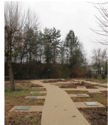
Travaux de création du nouveau cheminement en béton désactivé et pose des caves-urnes (Automne 2017)
