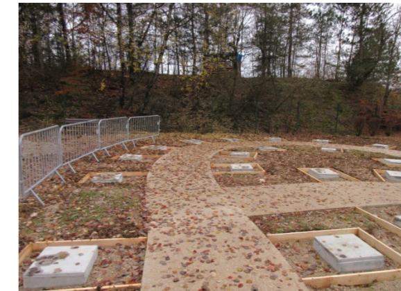
Travaux de création du nouveau cheminement en béton désactivé et pose des caves-urnes (Automne 2017)
