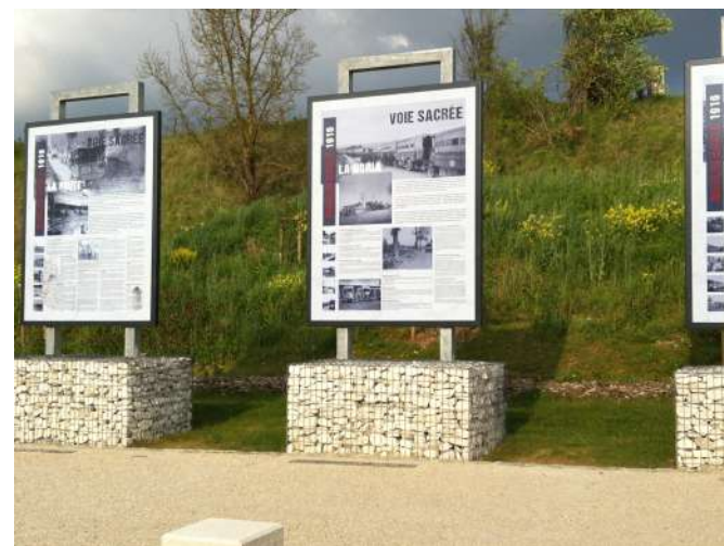
Signalétique : socle en gabion - structure cadre métal
