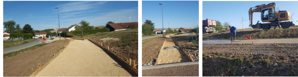
Création d'un cheminement piéton en entrée de village
